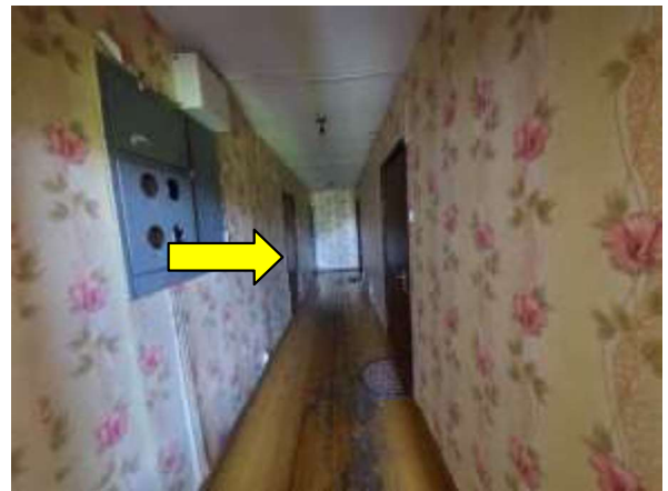
Kāpņu telpa un dzīvokļa Nr.8 izvietojums tajā
